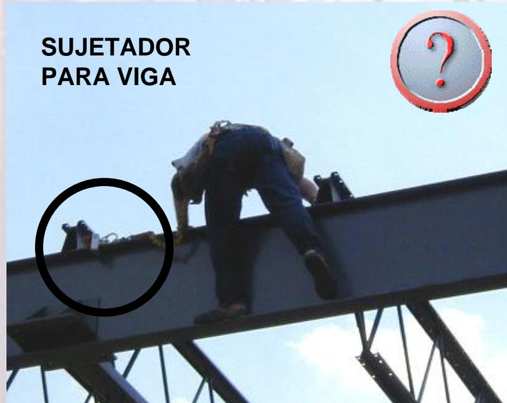
Introduzca totalmente la clavija y apriete el sujetador.
